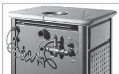
Detail připojení pojistného ventilu
